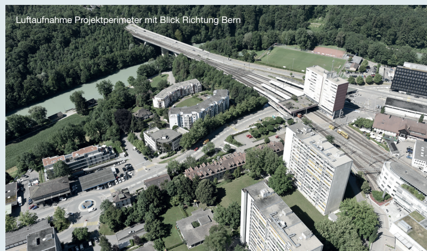
Blick von der Worblaufenstrasse
